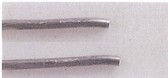
写真3 破断した素線の外観
